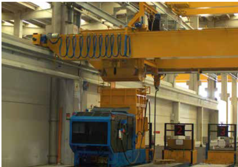
GRÚA DE VACIADO PARA LA PRODUCCIÓN DE LOSAS HUECAS PREFABRICADAS Y PAREDES CON EXTRUSORA Y MOLDEADORA DESLIZANTE
